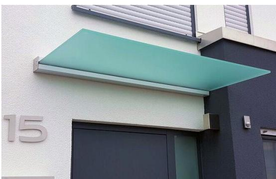
Das Vordachsystem Plan D weist eine klare, moderne Ästhetik auf. Die puristische Konstruktion besteht aus einer durchgehenden Wandklemmleiste und besonders reißfestem Spezialglas (SentryGlas). Durch die Kombination von Profil und SentryGlas wird die außerordentliche Tragkraft des Daches erzielt und eine trägerlose Dachausladung bis 1.100 mm ermöglicht. Mit Hilfe einer wandseitig montierten Keilleiste erhält das Dach eine 3° oder 5° Neigung.
